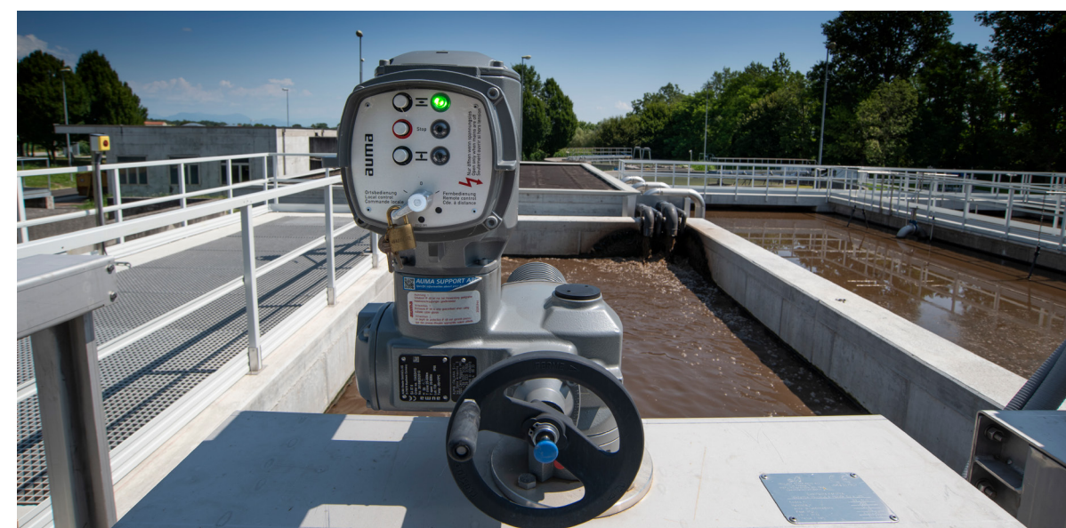
LTA / Impianto di depurazione di Cordenone (PN)
