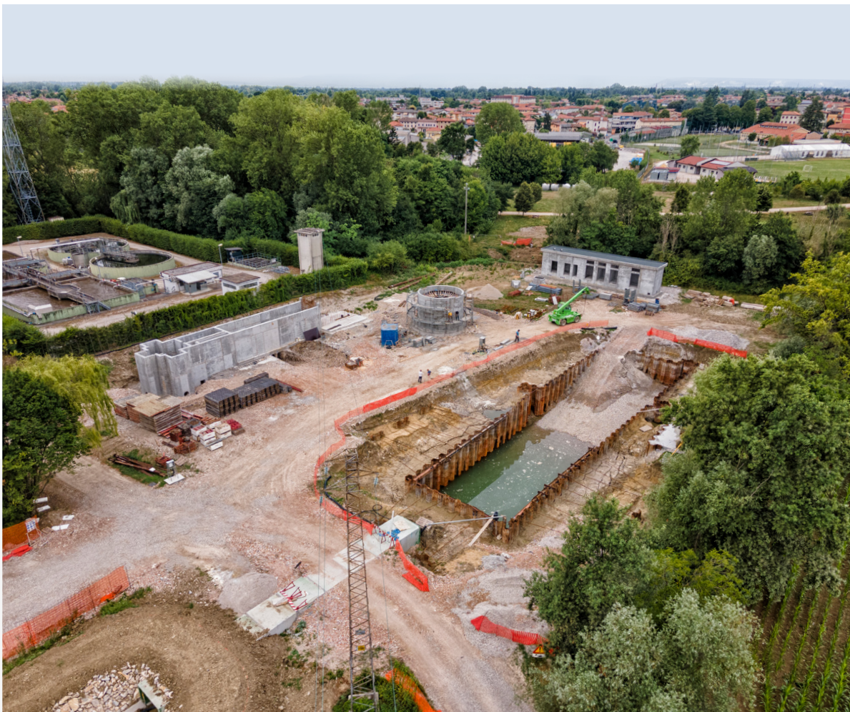
LTA / Cantiere impianto di depurazione di Aziano (Brescia) (PN)
